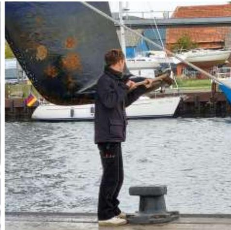
Rost und Pocken nichts zu erkennen. Steven kratzt die Pocken an der Unterseite der Kielbombe ab. Weil die Yacht darauf stehen wird, kommt man an diese Stellen später nicht mehr ran.
