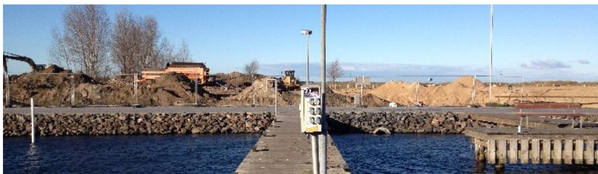
Der Blick von Steg 12 - rechts die Reste der Bunkerstation
